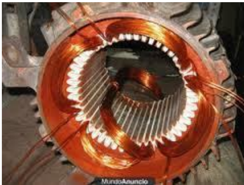
شکل (۶۰) کلاف و سیم پیچی در یک ماشین سه فاز
